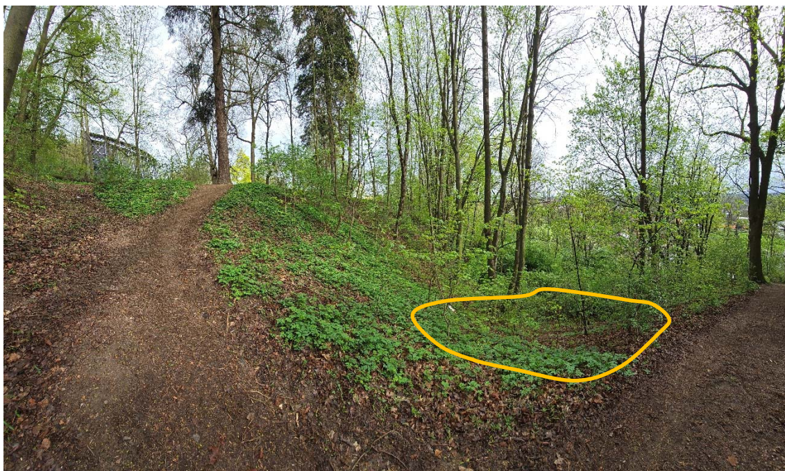
Obrázek 4: pohled na spodní partie svahu s vyznačenou pozicí vyústění svodného drénu přes plošný rozptyl kamenné úpravy vyústění drénu
