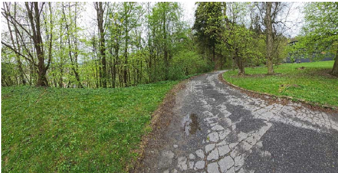
Obrázek 1: pohled na stávající úsek komunikace ve směru staničení nové a těleso parku, povrchové narušení asfaltového krytu je způsobeno pohybem nákladních souprav z výstavby letního kina a málo únosnými podmínkami tělesa
